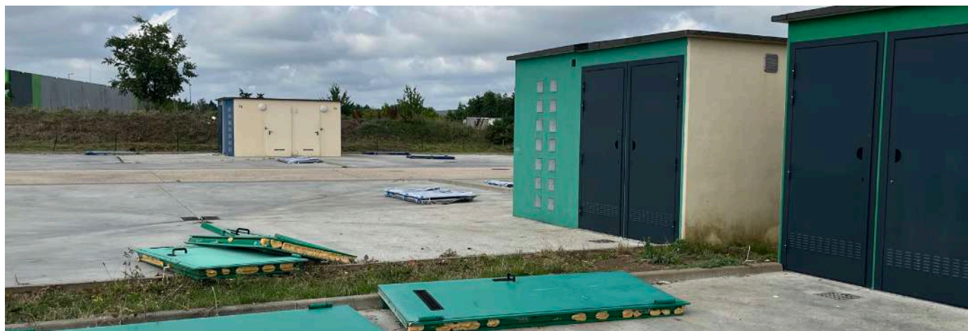
Changement des portes des sanitaires de l'aire d'accueil des gens du voyage - été 2025
