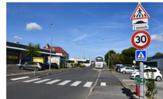
Réalisation d'un passage piéton rue des Roses - Servon
