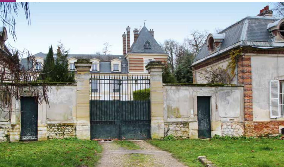
Château de Servon
